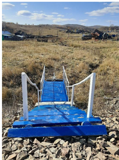
Фото после ремонта
